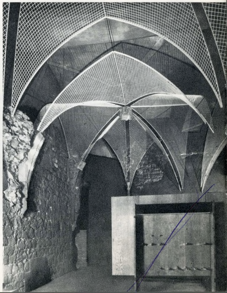
Visegrád, a XIII. századi lakótorony ún. Salamon-torony legfelső emeleti boltozatrendszerének didaktikai célú rekonstrukciója Visegrád. Reconstruction, pour des buts didactique de la voûte de l'étage supérieure de la tour Salamon Вишеград. Сделанная с целью достижения максимальной наглядности реконструкция сводов верхнего этажа донжона (т. н. башни Шоломона)
