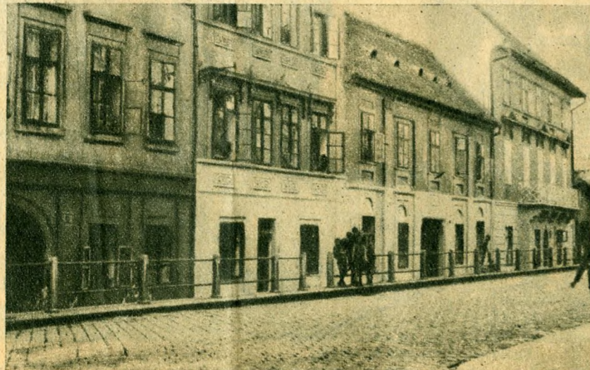
A Döbrentei-utca „elsüllyedt” fele.
