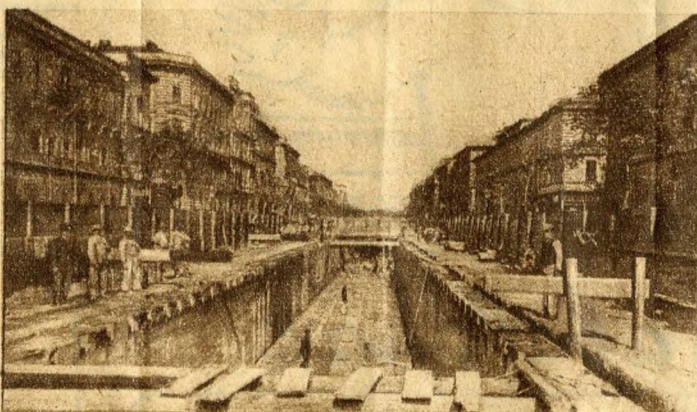
A régi, 1896-ban épített budapesti földalatti alagút készítése — mint egykorú képünk is mutatja — nyílt gödörben folyt. Ez természetesen megakasztott minden forgalmat. Csak az úttest közepén lehetett vezetni, mert nem mélyvezetési volt és így le kellett volna bontani a házakat is. Az új mélyvezetési megoldás mellett zavartalanul folyó forgalma
