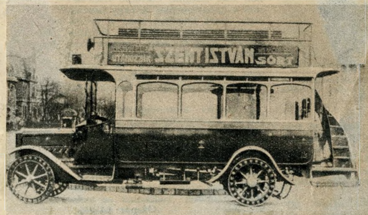
MARTA-gyártmányú autóbusz 1915-ből, a háborús anyaghiány következtében gumibroncsok helyett rugós vasabroncsokkal
