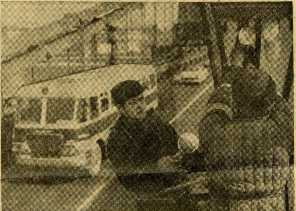
A villanszerelők higanygőzöket csavarnak a Lánchíd kandelábereibe. (MTI foto, — Kovács felv.)
