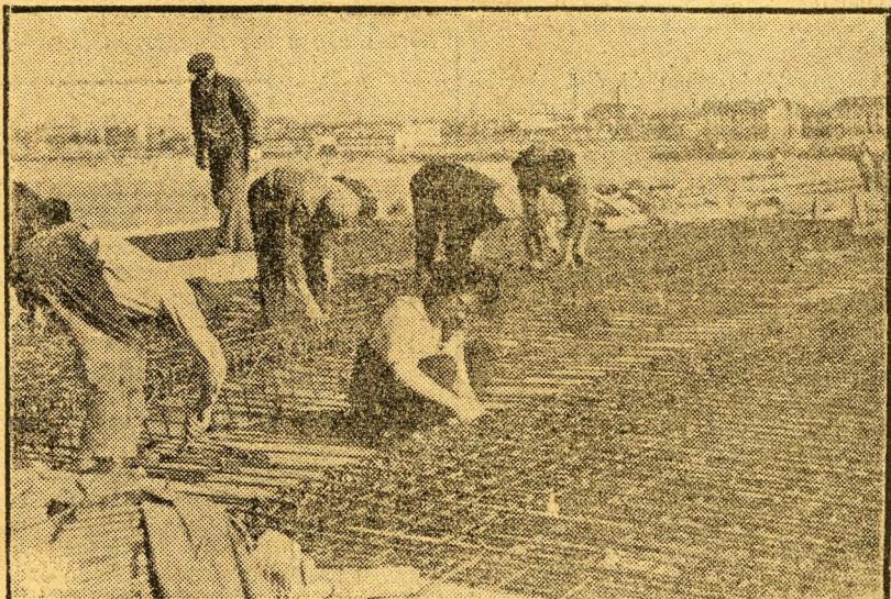
A vasbetonszerkezet vaspálcait szerelik össze az Árpád-híd dolgozói Luckó Mihályné is elsajátította ezt a munkát
